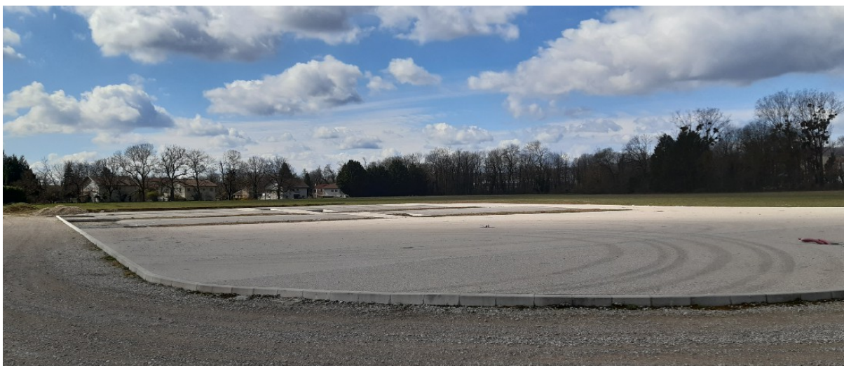
Vue du site du futur projet solaire - plateforme en béton brossé et bordures de trottoirs présents sur la zone (ancien projet aménagement SEMCODA)
